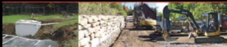
INSTALLATION DE FOSSE SEPTIQUE
